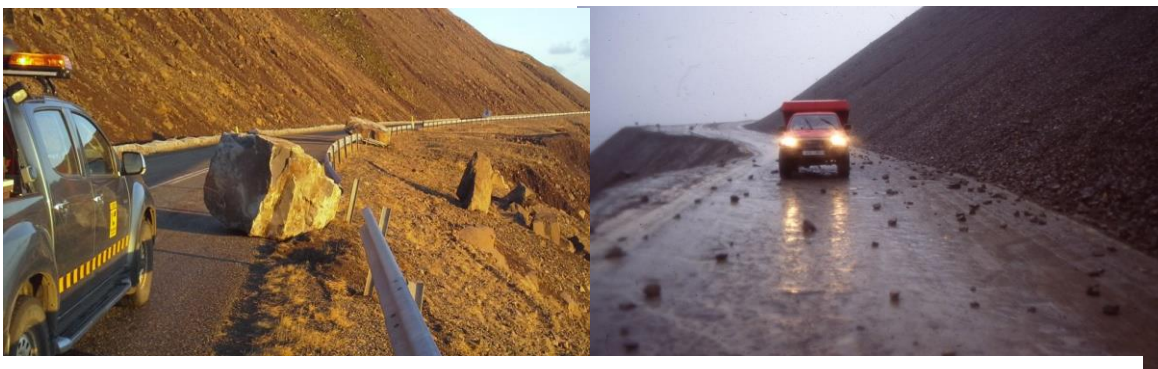
Mynd 10. Þar sem vegir liggja í sæbröttum hlíðum, t.d. í Hvalnesskriðum og Kambanesskriðum, getur hækkandi sjávarstaða aukið grjóthrun og skriðuföll.
