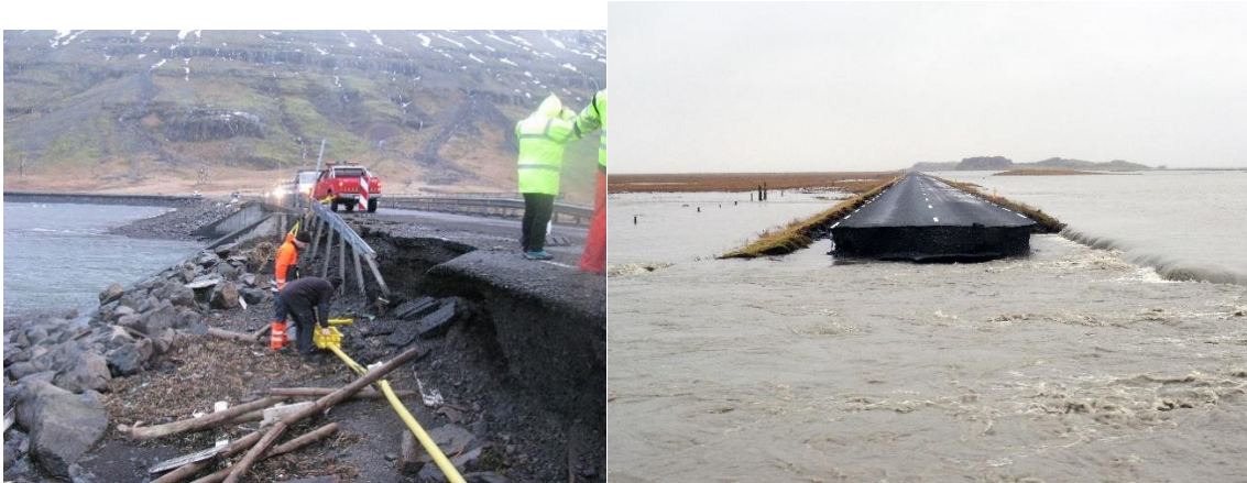
Mynd 9. Vatnsflóð vegna úrhellis eða asahláku valda reglulega skemmdum á vegum. Myndin sýnir rof í vegi við Eskifjarðará og á Hringvegi við Hólmsá.
