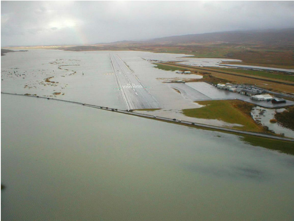
Mynd 16. Flóð vegna mikillar úrkomu, sérstaklega asahláku, geta valdið miklum truflunum á þjónustu flugvalla. Myndin er frá Egilsstaðaflugvelli árið 2002. Sambærilegt flóð varð á Siglufirði árið 2020.
